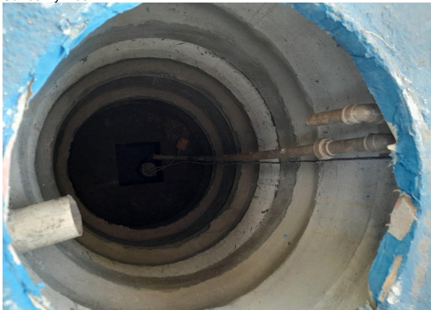
Fonte: Auditoria (vistoria realizada em 19/09/2023).
