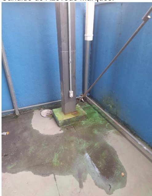
Figura 5 - Tubulação hidráulica executada na EMEF Des. Joaquim Candido de Azevedo Marques.
