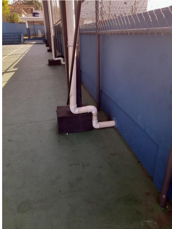
Figura 9 – Reparo efetuados no muro limitrofe entre a quadra e a calçada pública.
