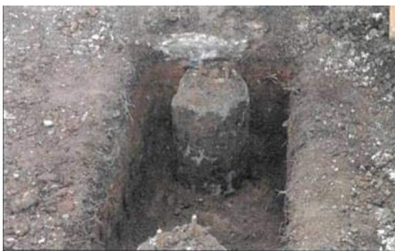
Figura 2 - Imagem de estaca raiz executada durante o período da medição nº 02 da EMEF Amélia Rodrigues de Oliveira.
