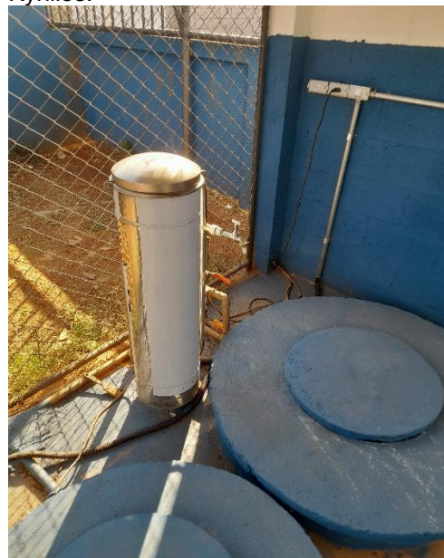
Fonte: Auditoria (vistoria realizada em 19/09/2023).
